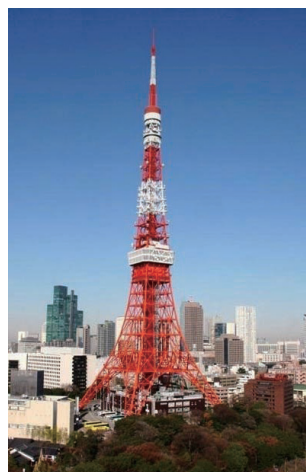
图7 日本东京铁塔
